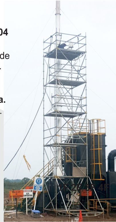
TRABAJOS EN ALTURA CON GEOPARK EN TAURAMENA
