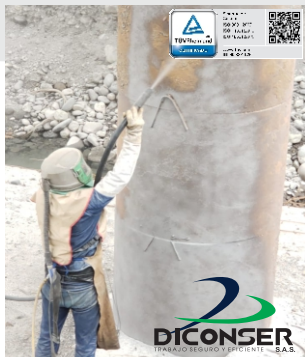
SANDBLASTING PUENTE GUAYURIBA
